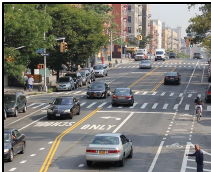
Linie rozdzielające pasy ruchu, zatoki, pasy skrętu w lewo
